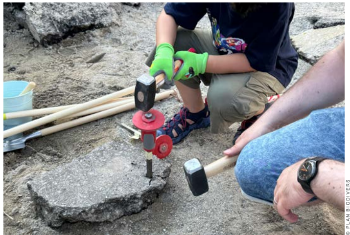
Asphaltscholle knacken mit Hammer und Meissel.
